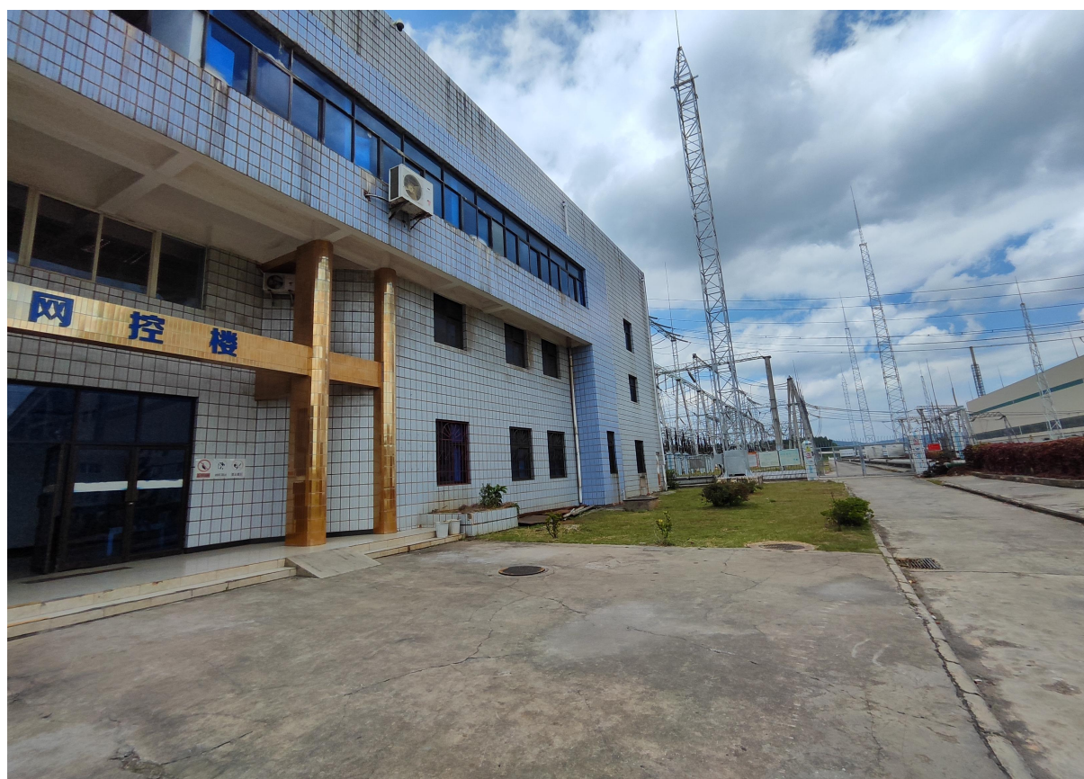
图10 升压站西面曲靖电厂一期220kV升压变及西北面网控楼
