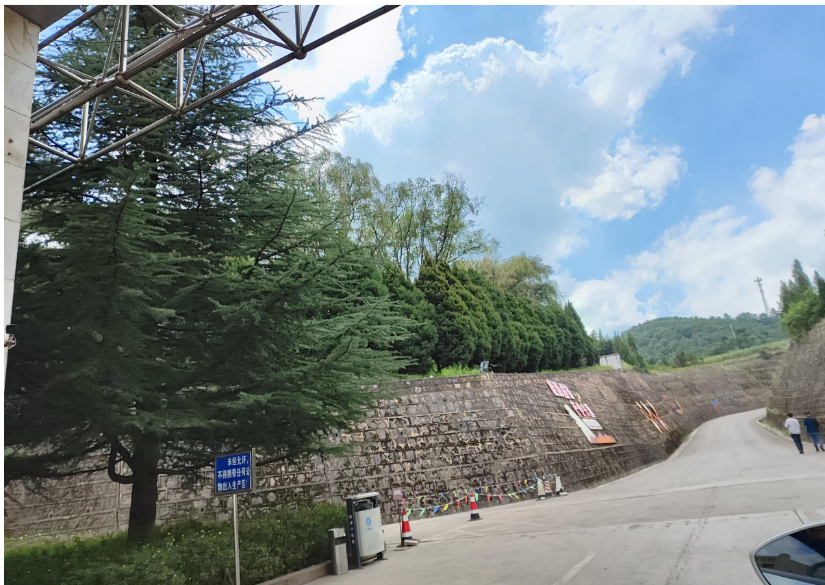
图7 升压站东面曲靖电厂进厂道路
