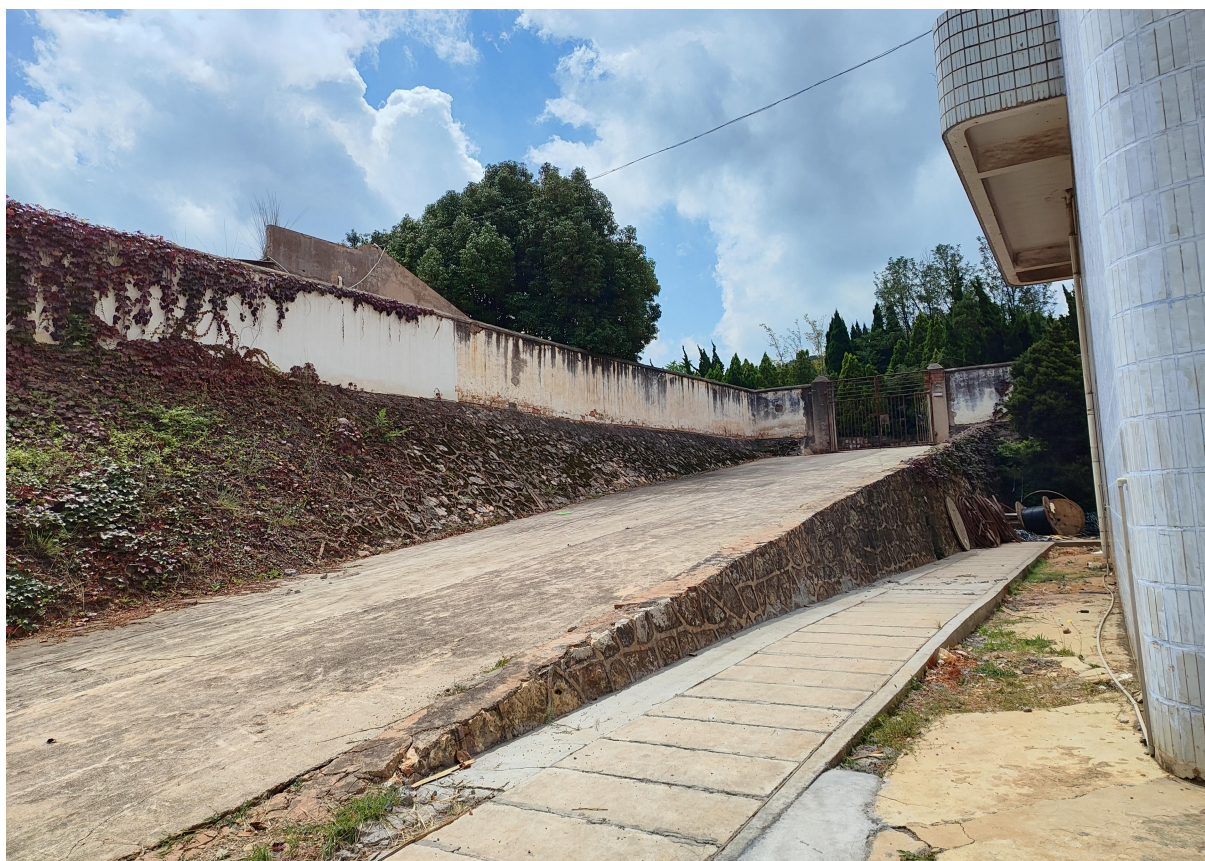
图9 升压站西北面进站道路
