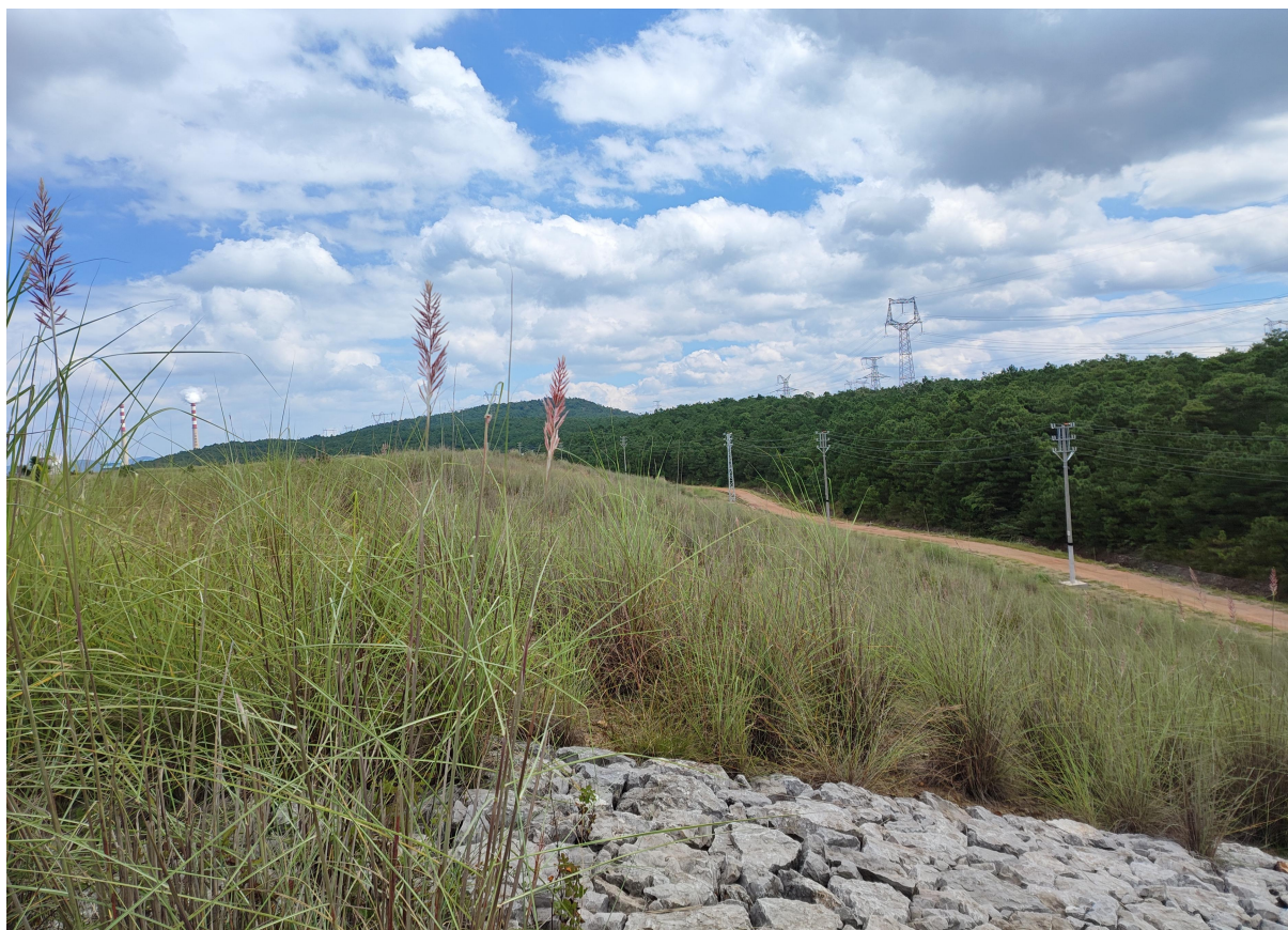
图 4 东南面灰场坝基外侧坡面
