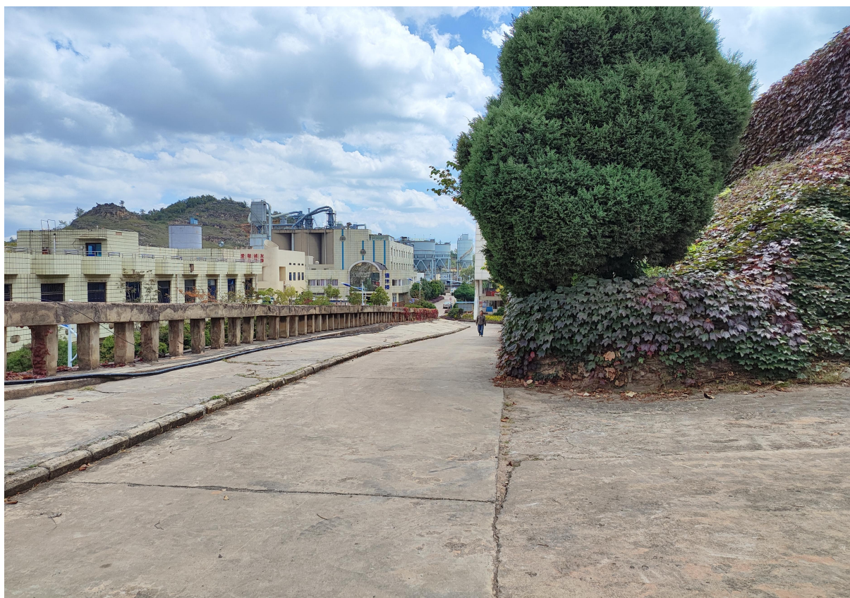
图8 升压站北面进站道路
