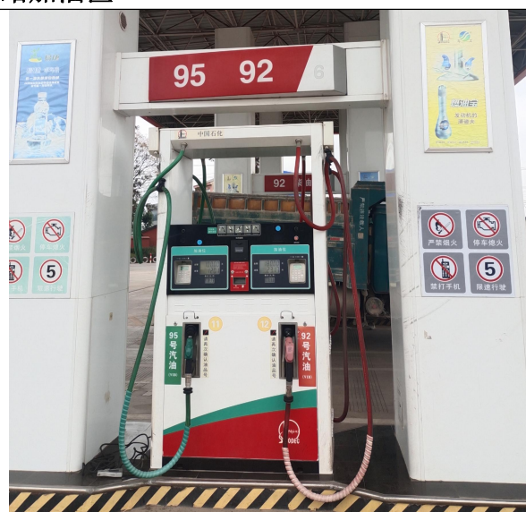
图 5 汽油加油机
