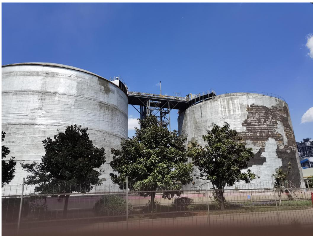
图 2-5 常压液氨储罐
