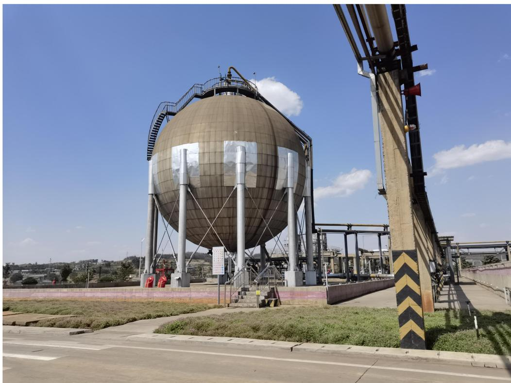
图 2-4 加压液氨储罐
