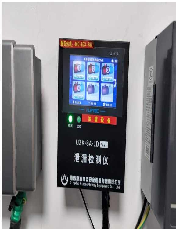
图 10 油罐泄漏检测仪
