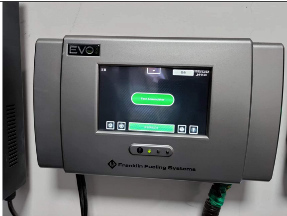
图 8 油罐高低液位检测系统
