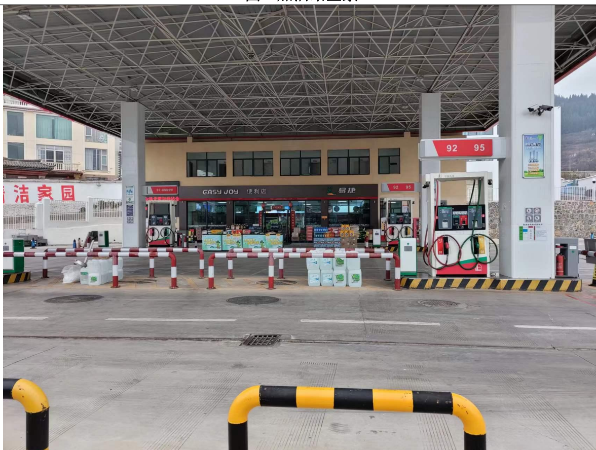
图 3 加油站储罐区
