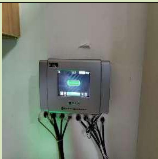
图 8 油罐高低液位检测系统
