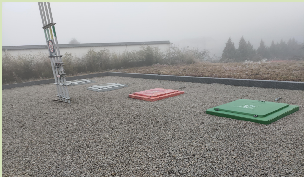
图 3 加油站储罐区
