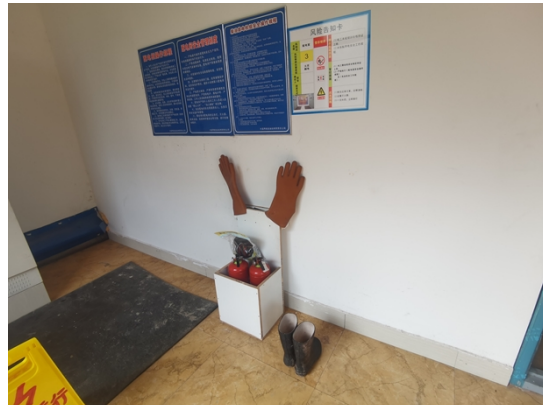
配电室应急器材
