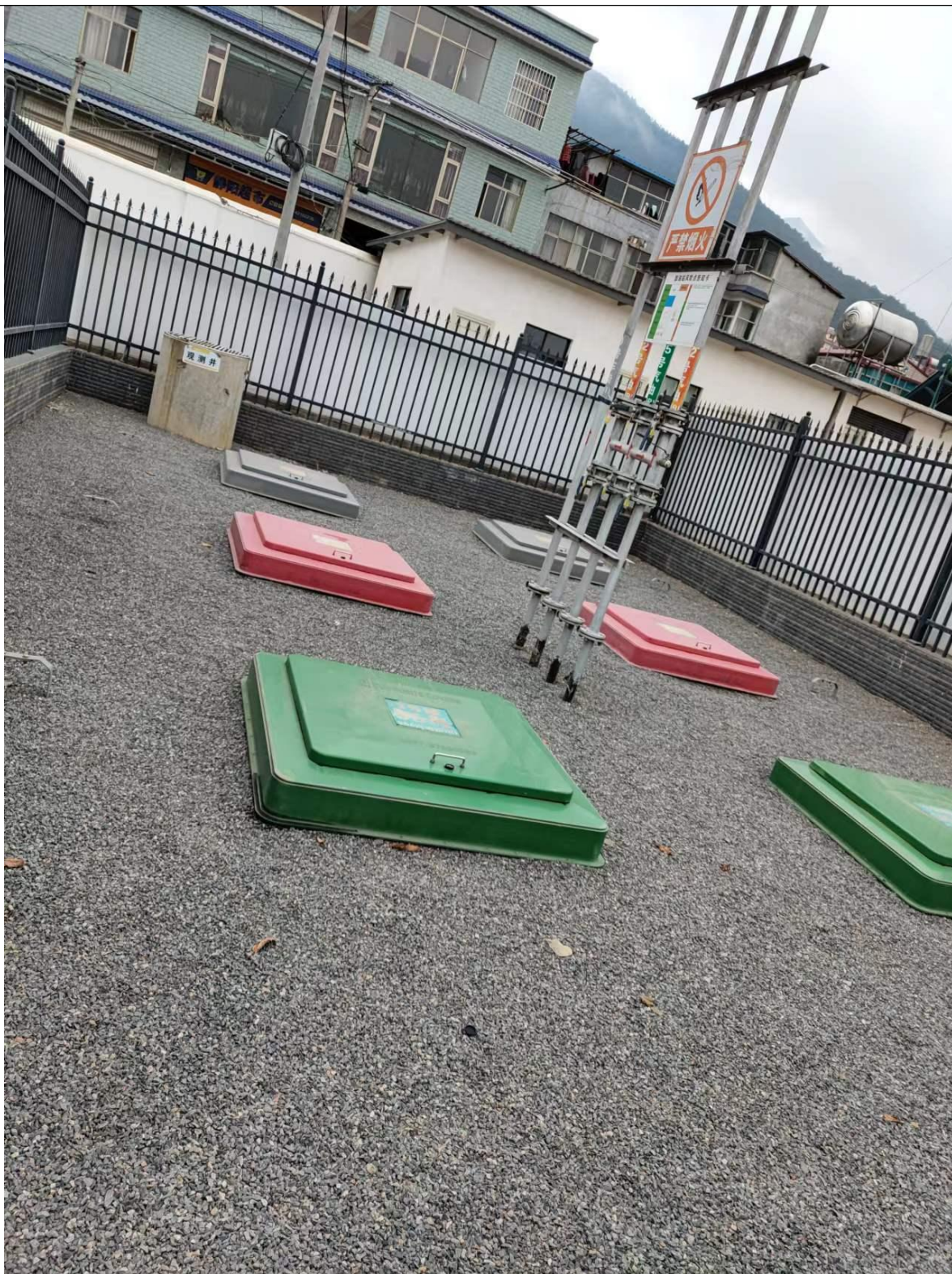
图 2 加油站储罐区
