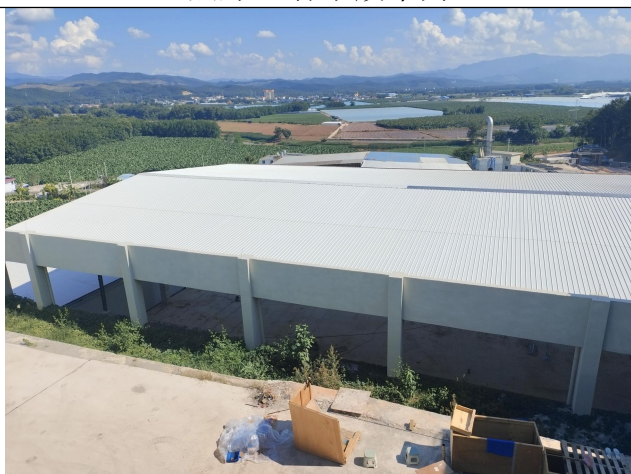
照片 10 厂区周边环境
