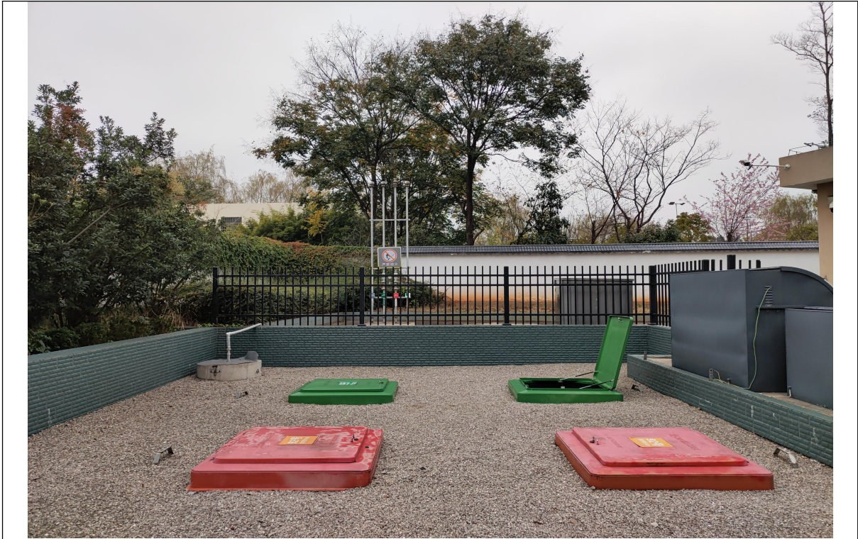
图 3 加油站油罐区
