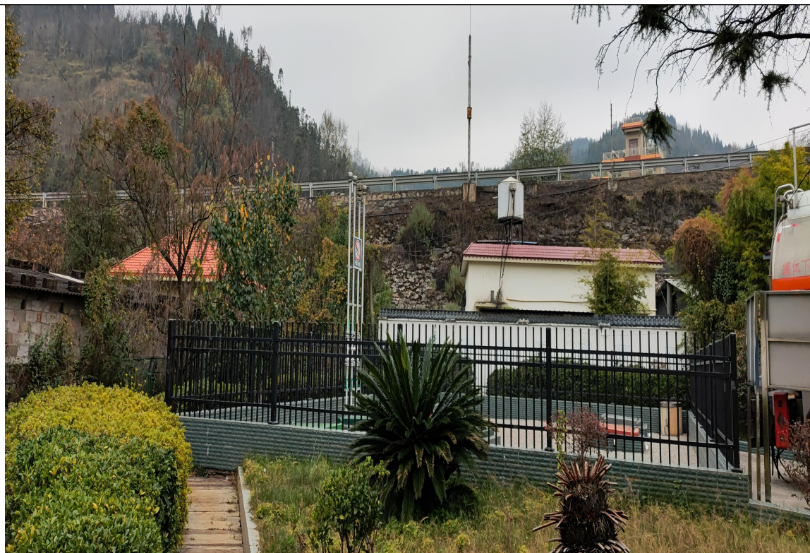
图 3 加油站油罐区
