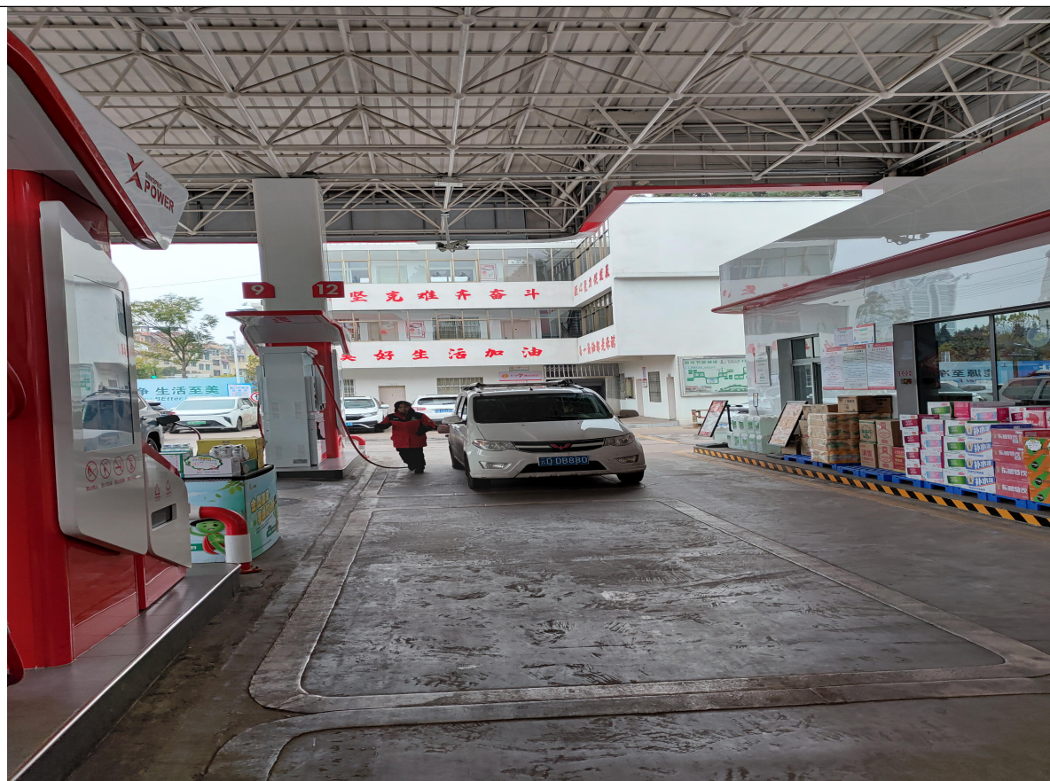
图 2 加油站加油区
