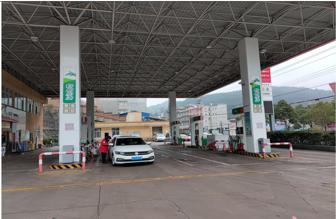
图 3 加油站加油区
