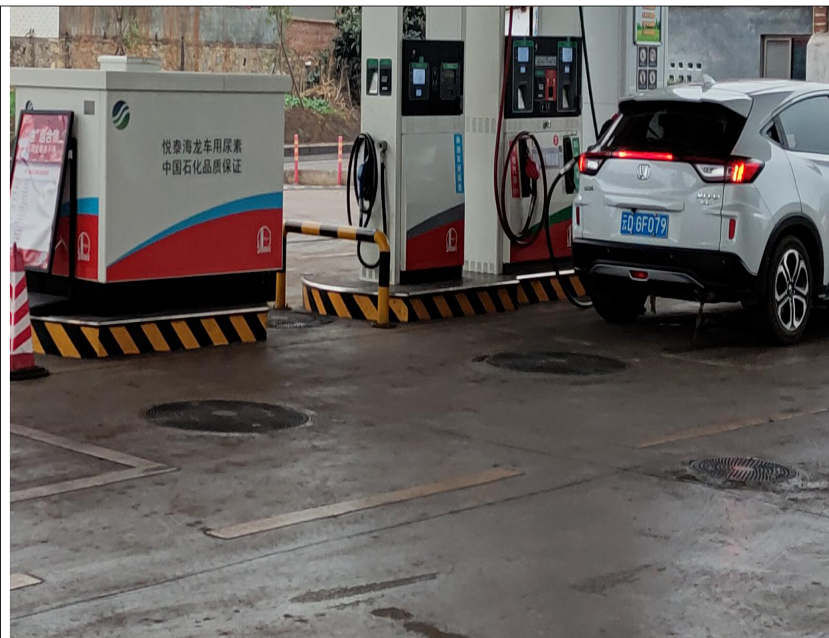
图 3 加油站储罐区
