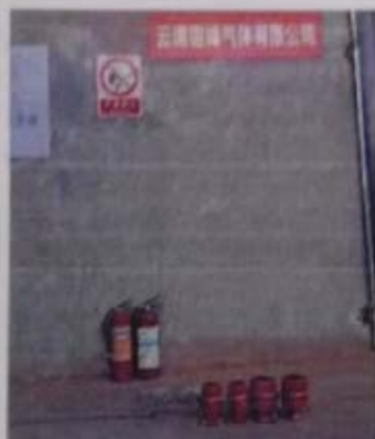
整改情况照片
