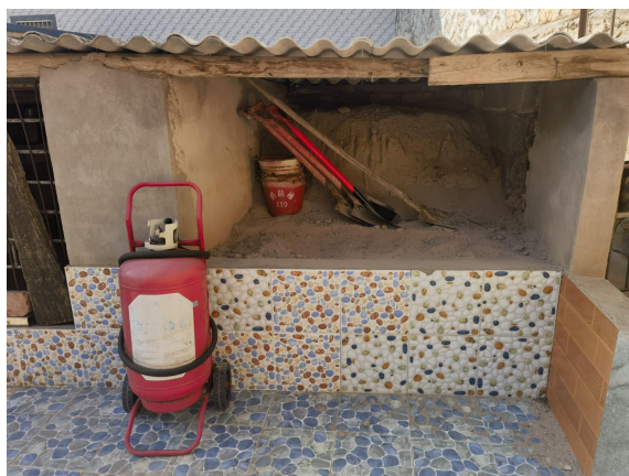
油罐区消防器材
