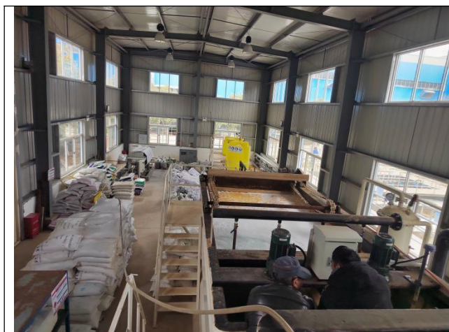
电泳污水处理站
