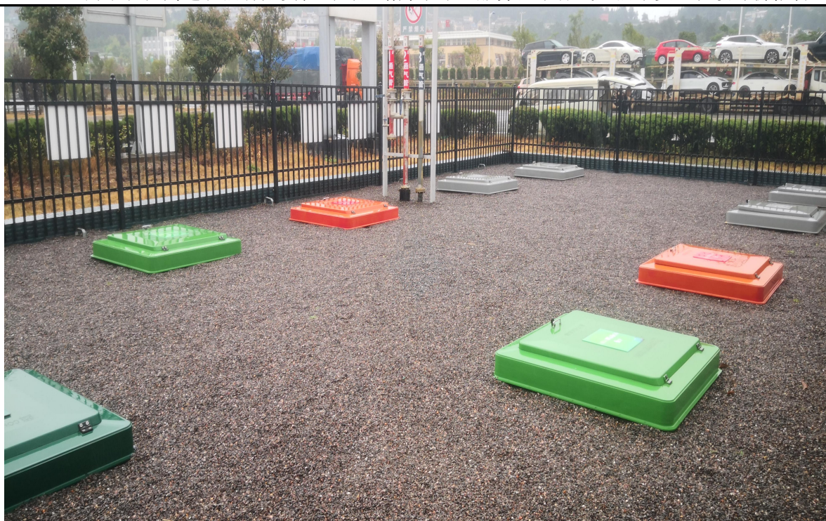
图 3 加油站储罐区
