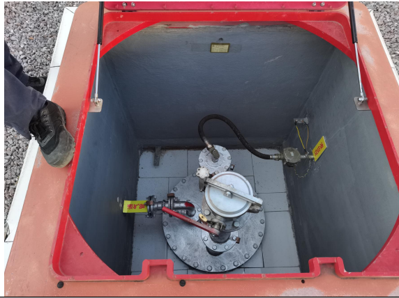
图 11 油罐操作井-0#罐
