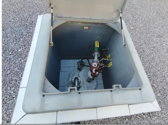
图 11 油罐操作井-0#罐
