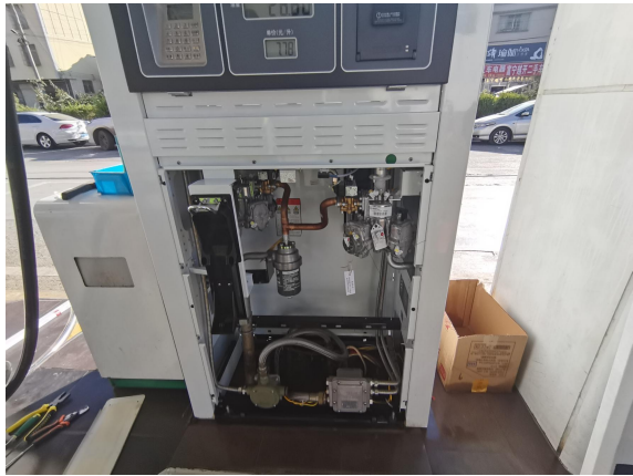
图 8 柴油加油机-内部
