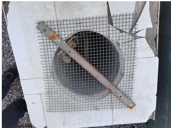
图 17 油罐通气管
