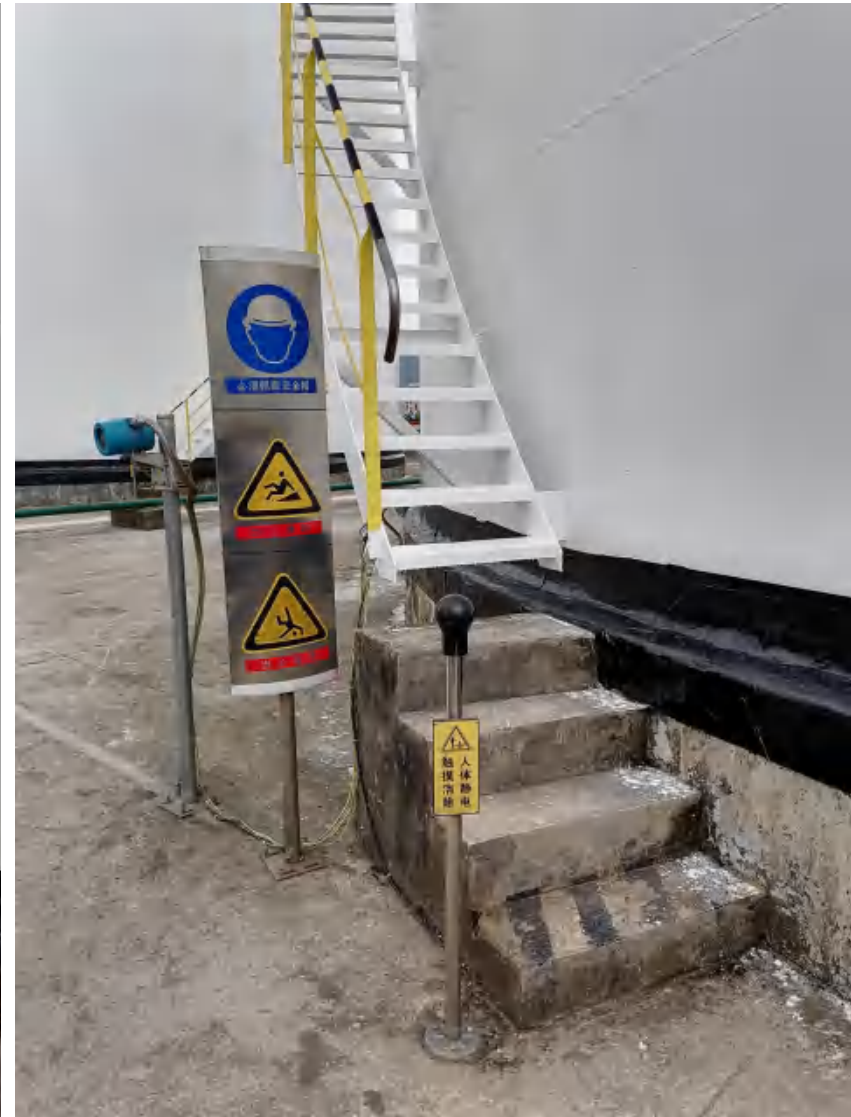
上罐盘梯入口
