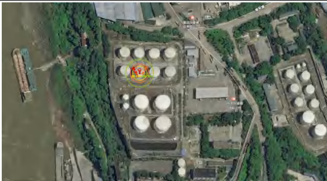
G-03-050 汽油储罐
