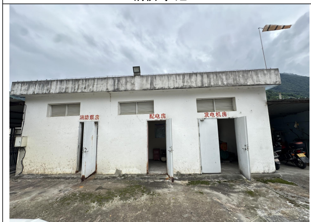
发电机房、配电房、消防泵房
