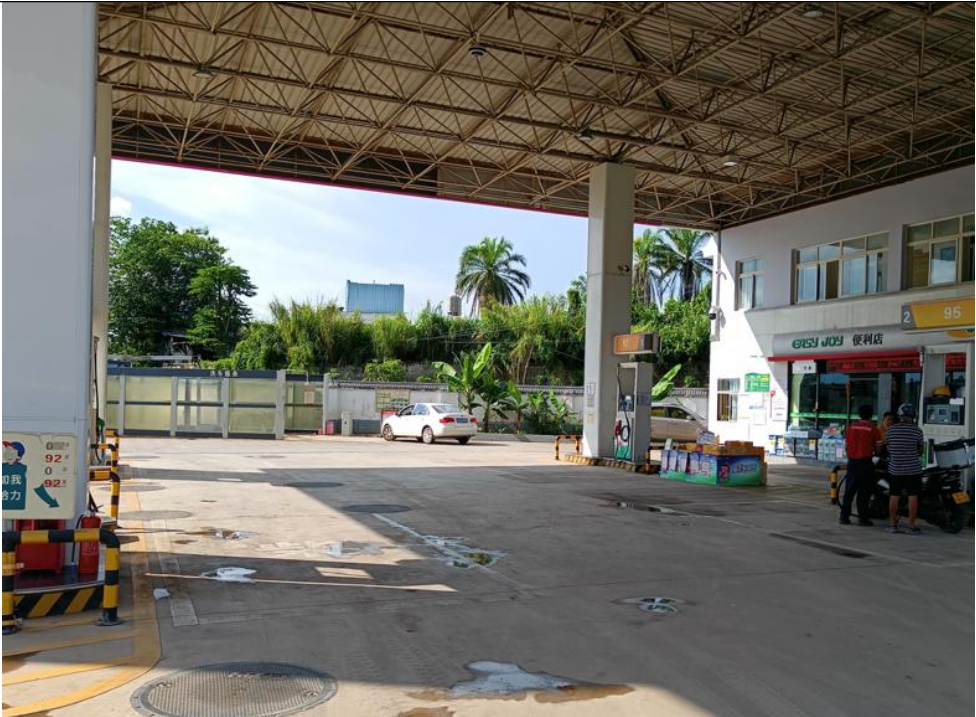
图 3 加油站加油区
