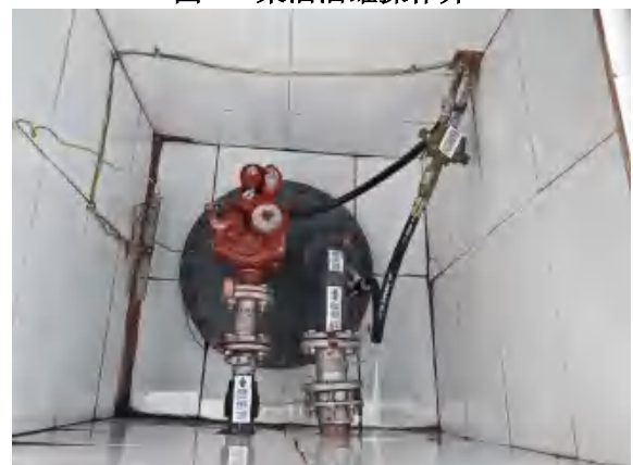
图 12 柴油油罐操作井
