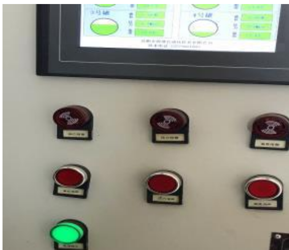
图 13 压力、温度、液位显示及声光报警
