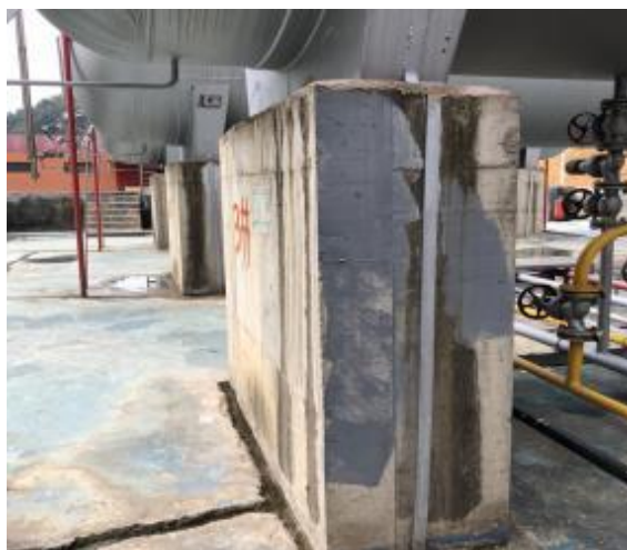
图 20 储罐区接地线
