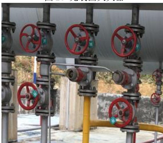
图 27 紧急切断阀门
