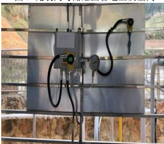
图 11 充装间压力表及压力传感器
