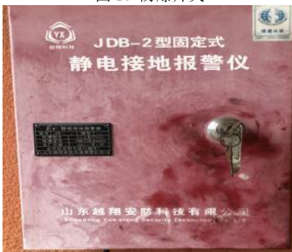
图 17 静电接地报警仪
