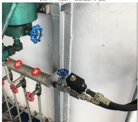
图 28 紧急切断电磁阀
