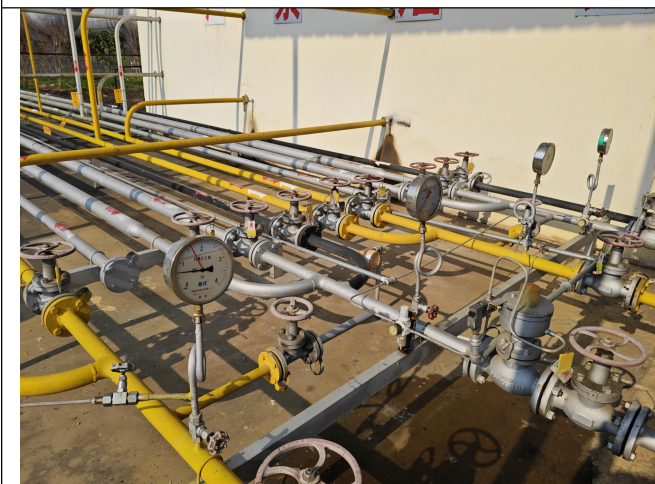
照片 17 气相管阀门和压力表
