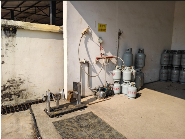
照片 9 液化石油气真空泵及抽残液罐装置区
