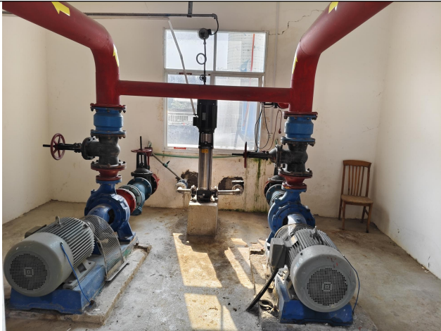
照片 10 消防水泵及高压注水泵
