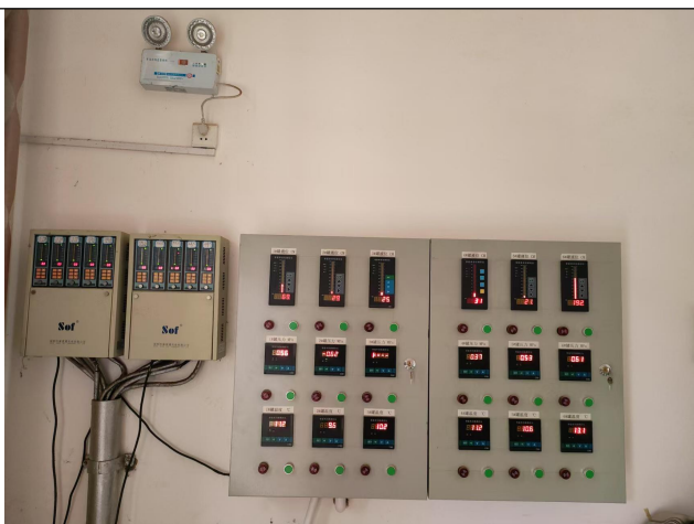
照片 18 可燃气体和液位、压力、温度探测报警装置
