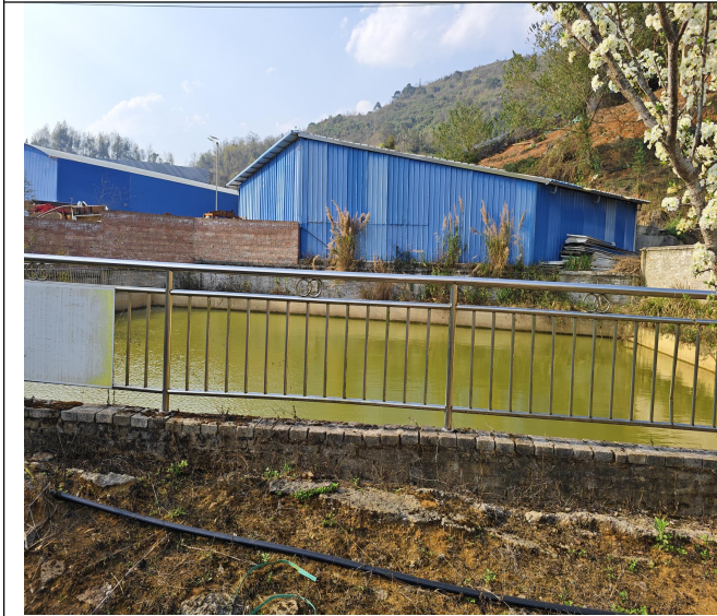
照片 27 消防水池
