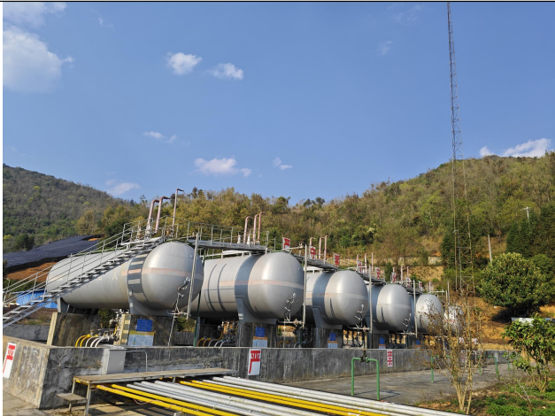
照片 12 工艺管线和放散管
