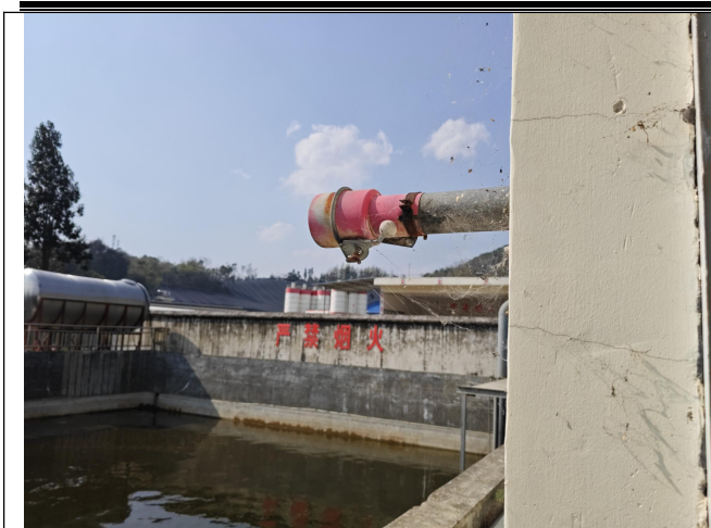
照片 19 发电机房设置的阻火帽
