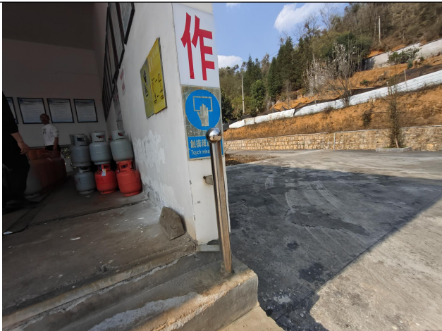
照片 8 静电接地桩
