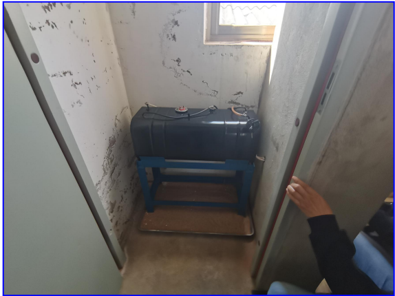
图 15 柴油发电机油箱
