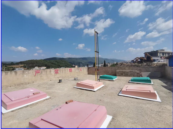
图 6 埋地油罐罐池
