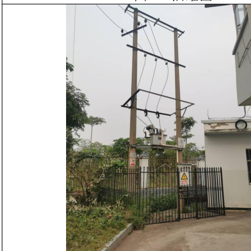
图 19 站内变压器
