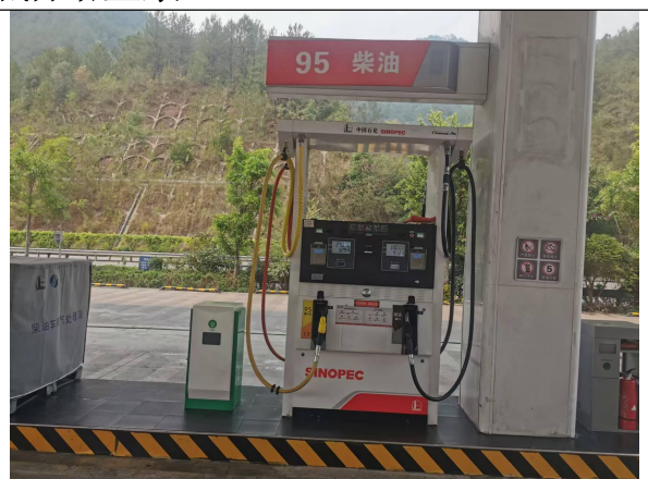
图 8 95#汽油、0#柴油加油机
