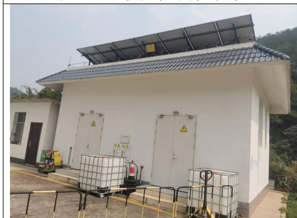
图 21 配发电房及屋顶光伏
