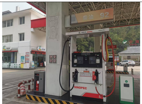
图 8 95#汽油、0#柴油加油机
