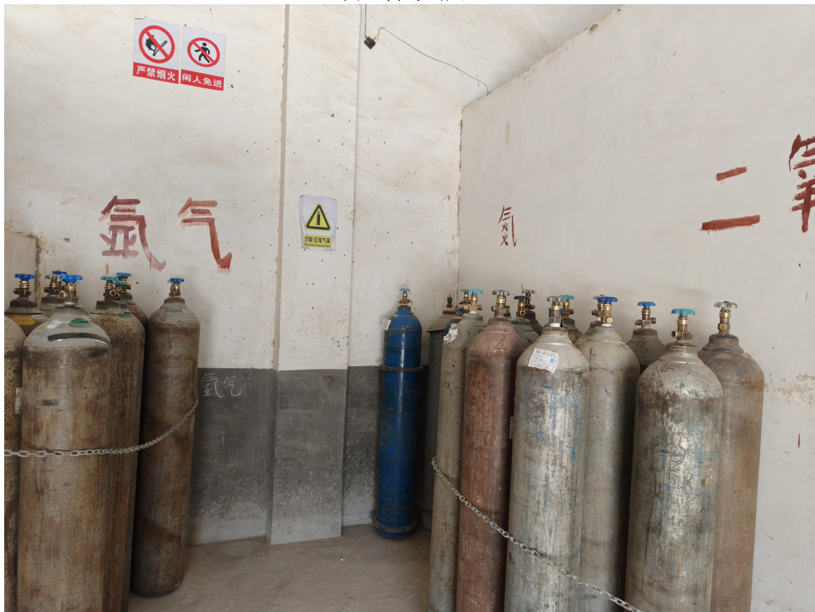
图 6 氩气、氮气、二氧化碳存放区
