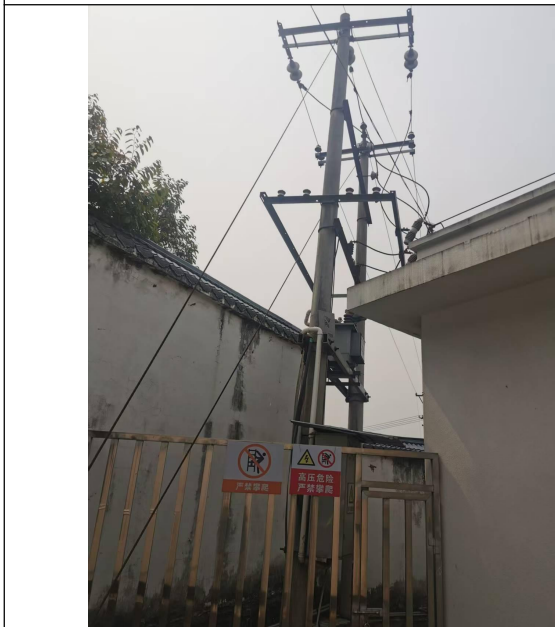
图 21 站内变压器
