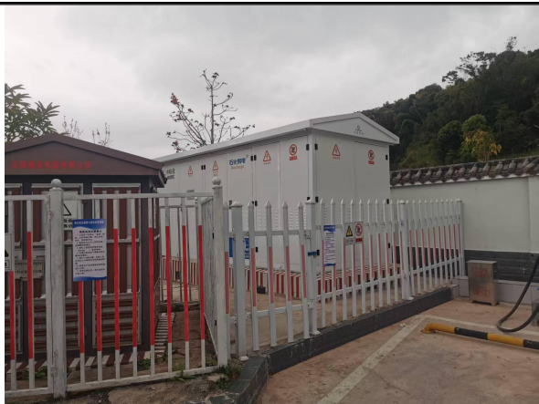
图 16 站内箱式变压器
